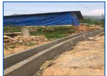
हुंगेनटार पनेरुगाऊ नाली निर्माण कार्य, वि.न.पा. ६
