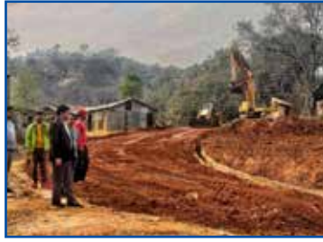
देवीघाट पुसुन्तार ख.भ.छापथोक सडक निर्माण वि.न.पा. ३
