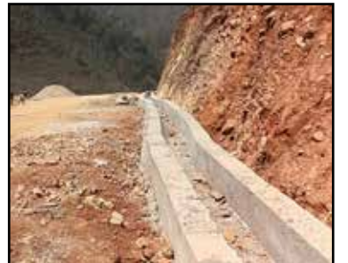
सडक नाली निर्माण
