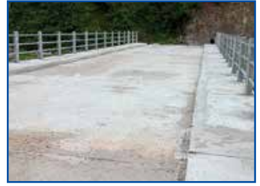
अजिङगरे रानीस्वाँरा पुल निर्माण निर्माण वि.न.पा. १३
