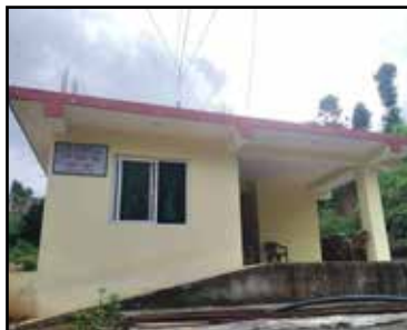
स्वास्थ्य चौकी भवन निर्माण
