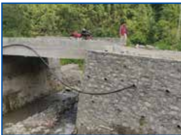
खुर्सानेखोला कल्भर्ट निर्माण कार्य, वि.न.पा. ८ र १३
