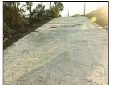
विजुरा माछापोखरी वस्ती सडक स्तरोन्नती
