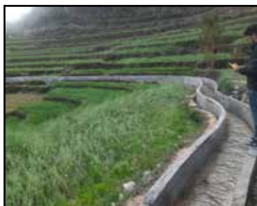
नागढुंगा कूलो निर्माण
