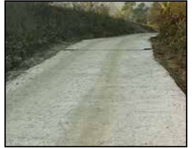
किम्ताङ टोल नाली निर्माण तथा तामाङ बस्तीबाट सिलटयाँकी जानेबाटो उकालो ढकाल निर्माण
