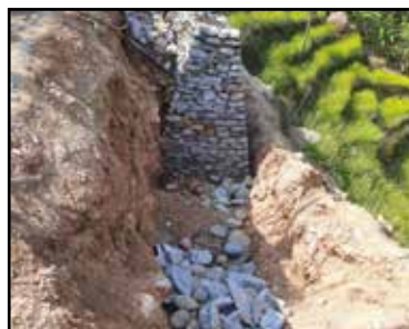
निर्माणाधीन नौबिसे कालीखोला सडक
