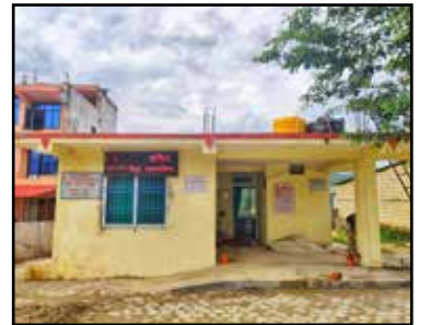
स्वास्थ्य चौकी भवन निर्माण
