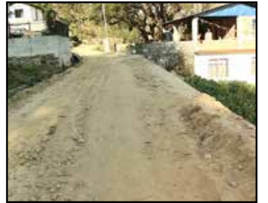
डुँडे आपको बोट जाने सडक निर्माण तथा मेसिनरी वाल निर्माण १
