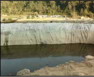
प्यास्तीक पोखरी निर्माण ९
