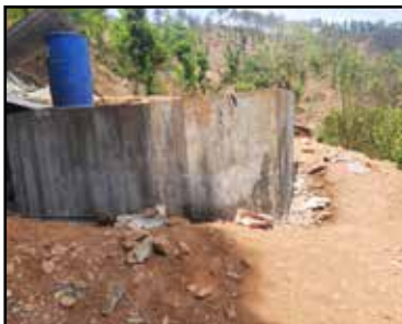
कठेरी खानेपानी ट्यांकी निर्माण
